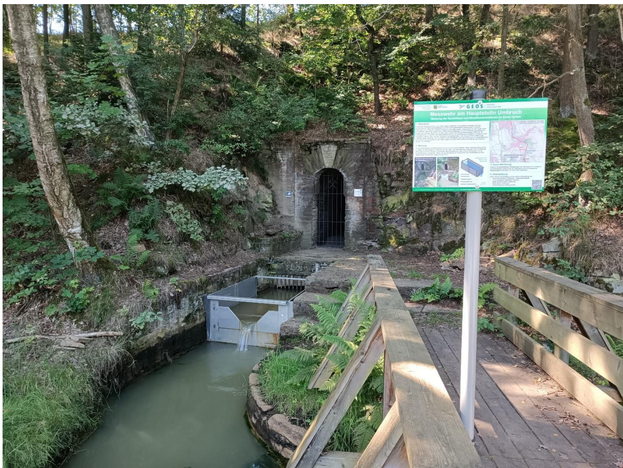
Abbildung 1 Messwehr am Hauptstolln Umbruch. Quelle: G.E.O.S. Ingenieurgesellschaft mbH
