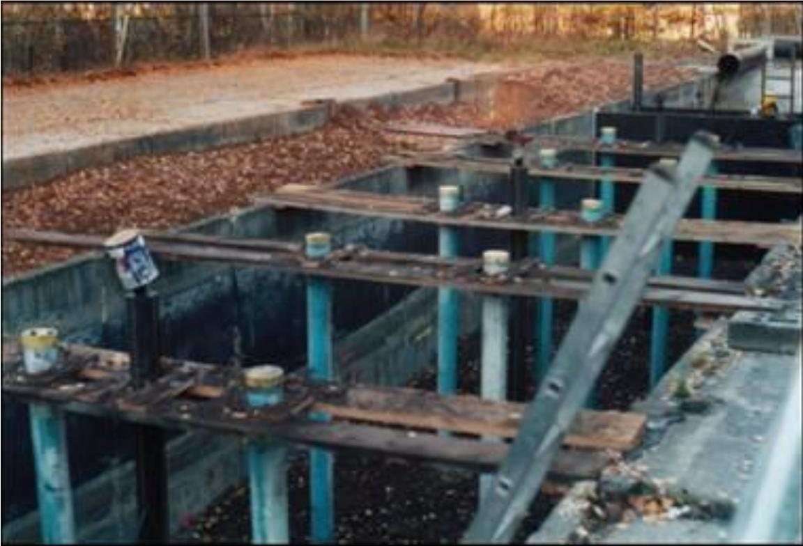
Abbildung 26: Aufbau des Wetlands und Installation der Probenahmerohre
